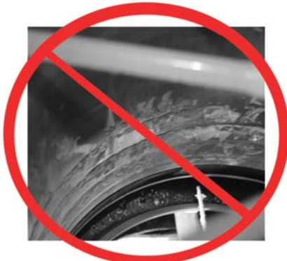
Inapropiado ajuste de la válvula TXV
