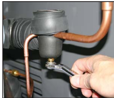
Ajustando la Válvula TXV
