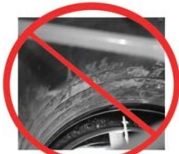
*Inapropiado ajuste de la válvula TXV*
